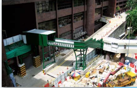
為配合車站出入口工程，香港大學黃克競樓的樓梯已經拆卸，並興建了一條臨時行人天橋連接黃克競樓及薄扶林道。
