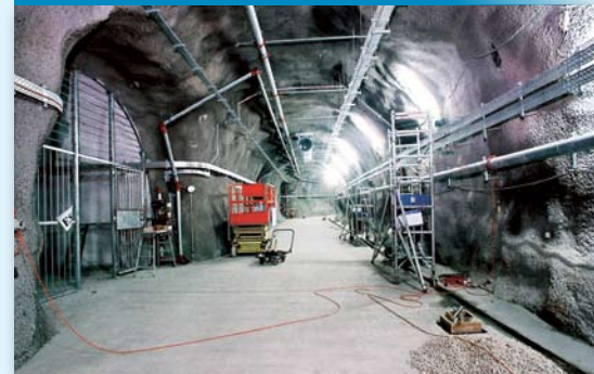
域多利道臨時爆炸品倉庫的隧道工程已經完成，現正進行內部裝修及機電工程。
