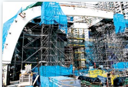
城西道重置堅尼地城游泳池工地的樁帽工程已經完成，現正進行頂部結構工程。
